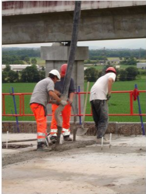
A l'aide d'une pompe à béton, bétonnage du clavage des dalles. Mortier de remplissage fluide
