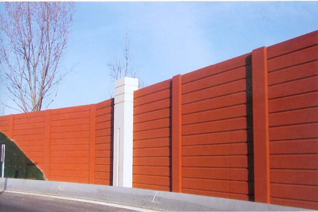
ÉCRANS ACOUSTIQUES DU PÉAGE DE L'AUTOROUTE A62
