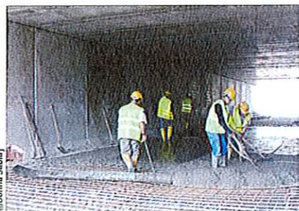
Les demi-radiers, d'un volume unitaire de 44 m 3 de béton, ont été coulés en une demi-journée.
