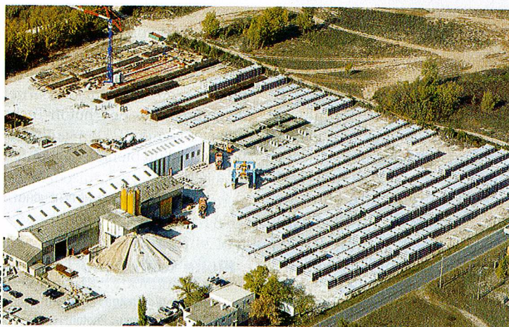
Bonna Sabla a totalement reconfiguré son site de Loyettes (Ain) pour assurer la production de 651 dalles (bâtiment rallongé au centre), la production des armatures (en haut), et organiser une aire de stockage des dalles (à droite).
